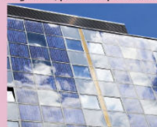
Figura 4.65 Edificio con paneles solares.
