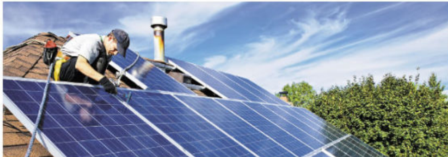
Figura 2.46 Instalación de sistemas solares fotovoltaicos.
