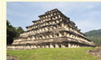
Figura 5.15 En la construcción de El Tajín se usó un concreto de peso normal con cal de piedra como agregado y cal puzolánica como cementante. Además, se usó piedra pómez para el concreto ligero.
